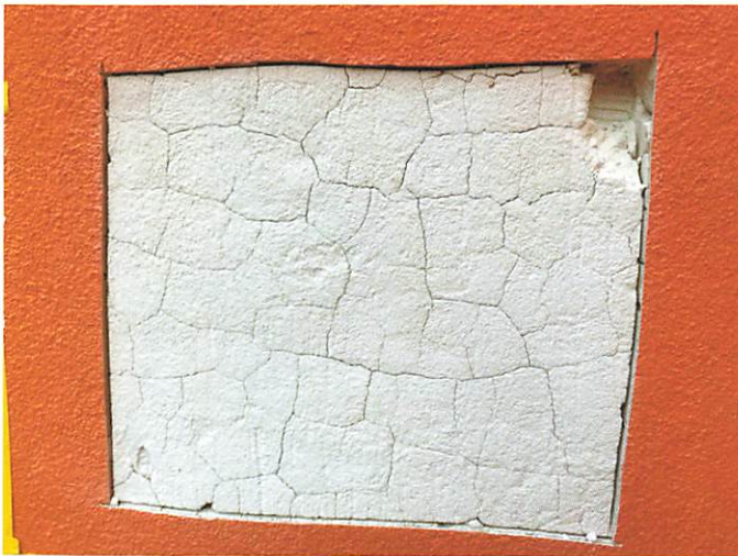
(2) Ausgeprägte Schwindrissbildungen im Dämmputz unter hohl- liegendem Deckputz
