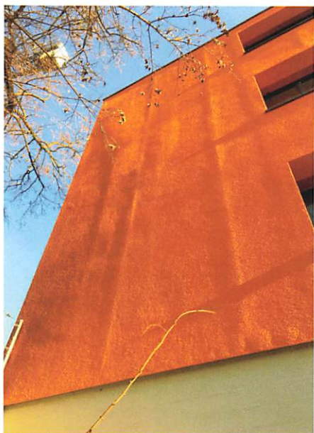
(1) Deutliche Putzablösungen und gut erkennbare Putzleisten durch massives Schwinden des Dämmputzes
